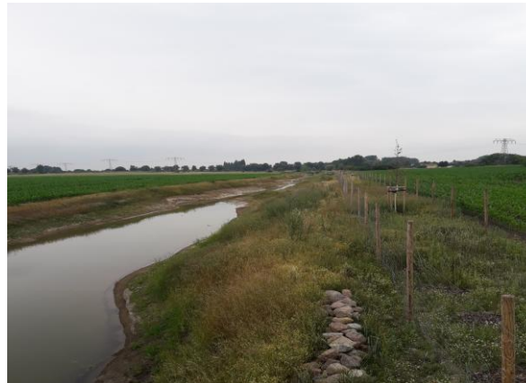
Renaturierter Graben mit Uferbefestigung
