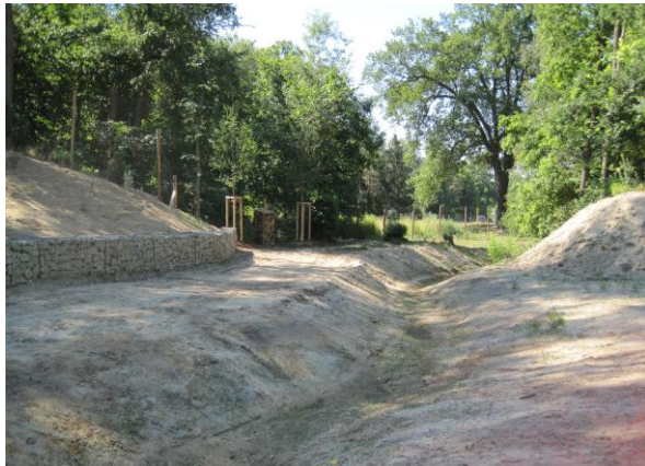
Gabionenbauweise im Bau
